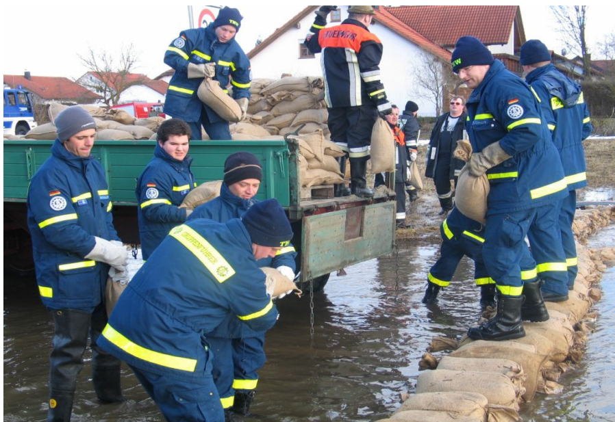
Abb. 4-49 Einsatz: Mobiler Hochwasserschutz durch das THW mit Sandsäcken (Bundesanstalt Technisches Hilfswerk 2006)
